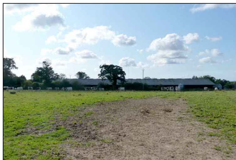
Image du nouveau bâtiment d'exploitation mis en évidence sur les photos aériennes. Etant données ses dimensions, il pourrait facilement s'intégrer dans un paysage bocager à condition de mettre en place quelques plantations.
